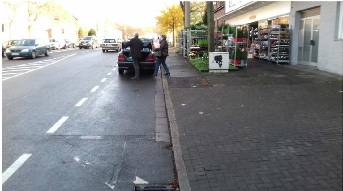
Bild 11 Parken auf dem Schutzstreifen. Wegen der großen Breite (über 2,00 m, wegen benachbarter Bushaltestelle) und mangels Fahrrad-Piktogrammen ist kaum erkennbar, dass es sich um einen Schutzstreifen handelt. Nach der Entwurfsplanung ist in diesem Abschnitt kein Fahrrad-Piktogramm vorgesehen. Es wird empfohlen, hier zusätzliche Fahrrad-Piktogramme einzuplanen, ebenso wie an anderen Stellen, an denen Fehlnutzungen offensichtlich häufiger auftreten.
