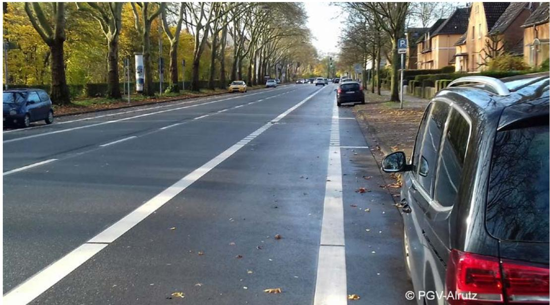
Bild 10 Abschnitt C östlich Elpenbachstraße, Fahrtrichtung Westen: auf der Nordseite halb aufgesetztes Parken auf ehemaliger Radwegfläche. Auch hier wird mit dem geplanten zusätzlichen roten Breitstrich ein 0,50 m breiter Sicherheitsraum erreicht.
