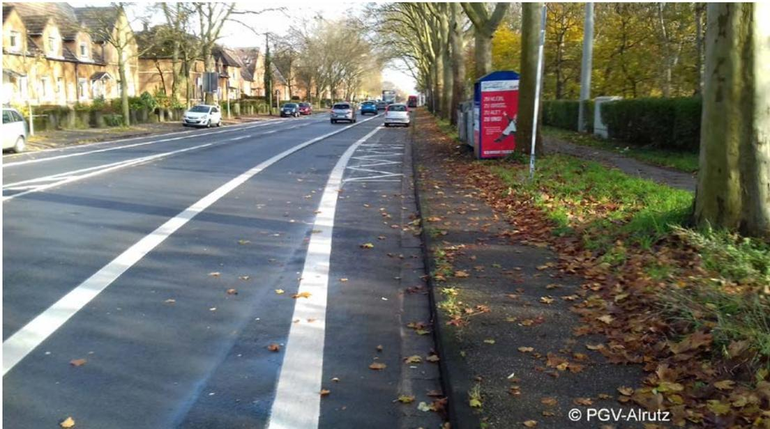
Bild 8 Abschnitt C östlich Elpenbachstraße: Südseite mit Parkstreifen von 2,00 m Breite neben Breitstrich als Begrenzung des Radfahrstreifens, aber ohne Sicherheitstrennstreifen. Mit dem geplanten roten Breitstrich beidseits innerhalb des Radfahrstreifens wird ein 0,50 m breiter Sicherheitsraum erreicht.
