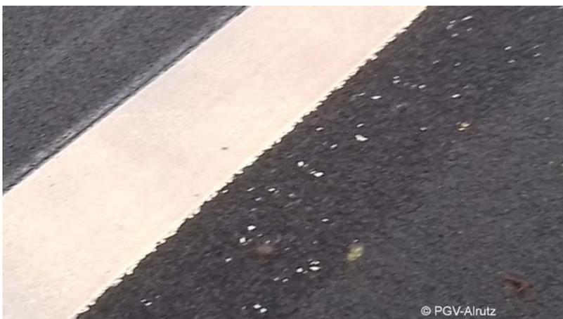
Bild 9 Abschnitt C östlich Elpenbachstraße: im westlichen Teilabschnitt von Abschnitt C wurde der Breitstrich so aufgetragen wie im Abschnitt B, aber anschließend wieder entfernt. Er wurde 0,25 m in Richtung der Fahrbahnmitte neu markiert.
